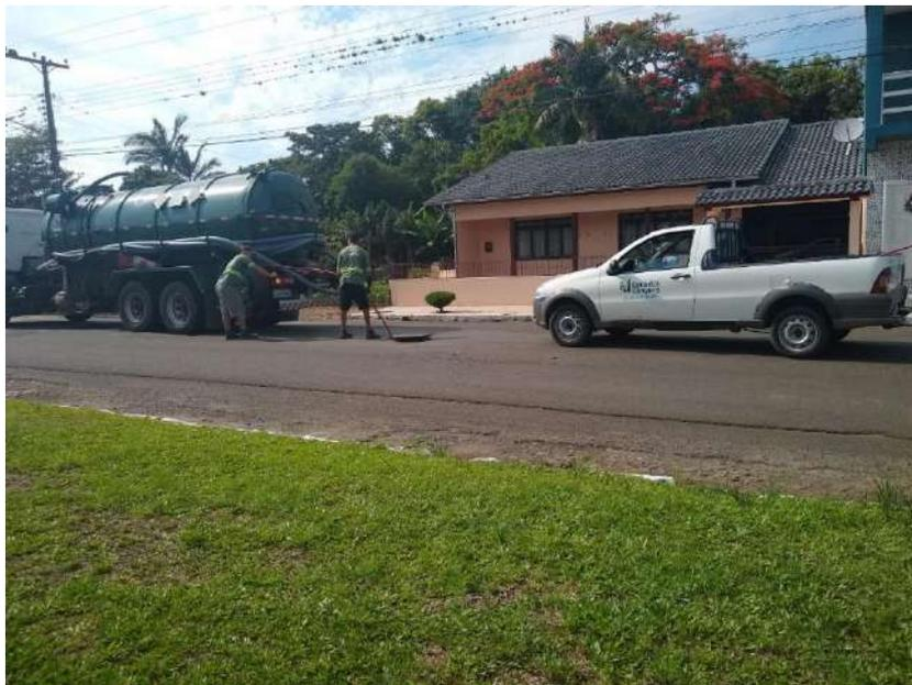
Foto 2 - Realização de limpeza de ramal da rede coletora de esgoto
